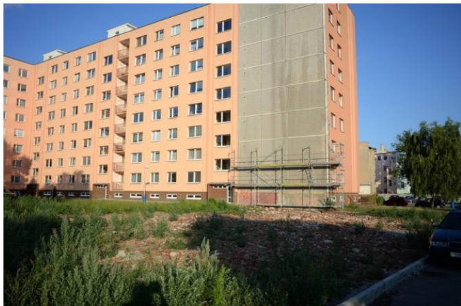
Nach dem Abriss: Juli 2018 – nur noch Ziegelreste auf dem Rasen künden vom alten Hauptgebäude des Hotels Imperator U Červeného kostela 11/40, Trnovany, 415 01 Teplice
